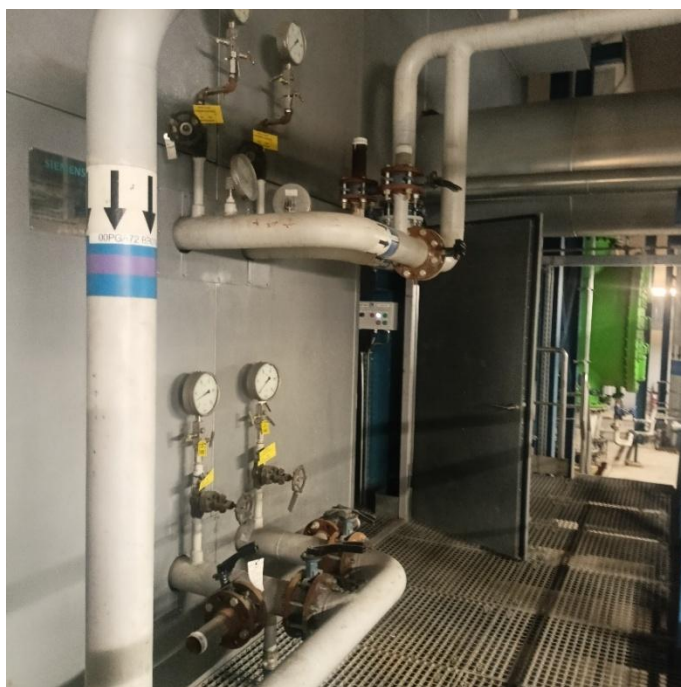
Zdjęcie nr 2 Króćce przyłączeniowe na instalacji chłodzenia oleju turbinowego
