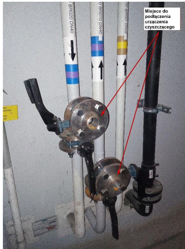
Zdjęcie nr 3. Miejsce podłączenia urządzenia czyszczącego do rurociągów wody chłodzącej wentylator
