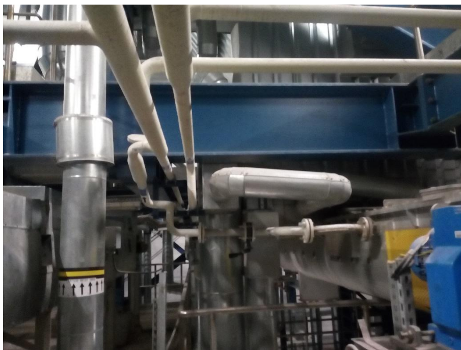
Zdjęcie nr 12 Widok ogólny układu chłodzenia przenośników pod kotłowych wraz z wymiennikami
