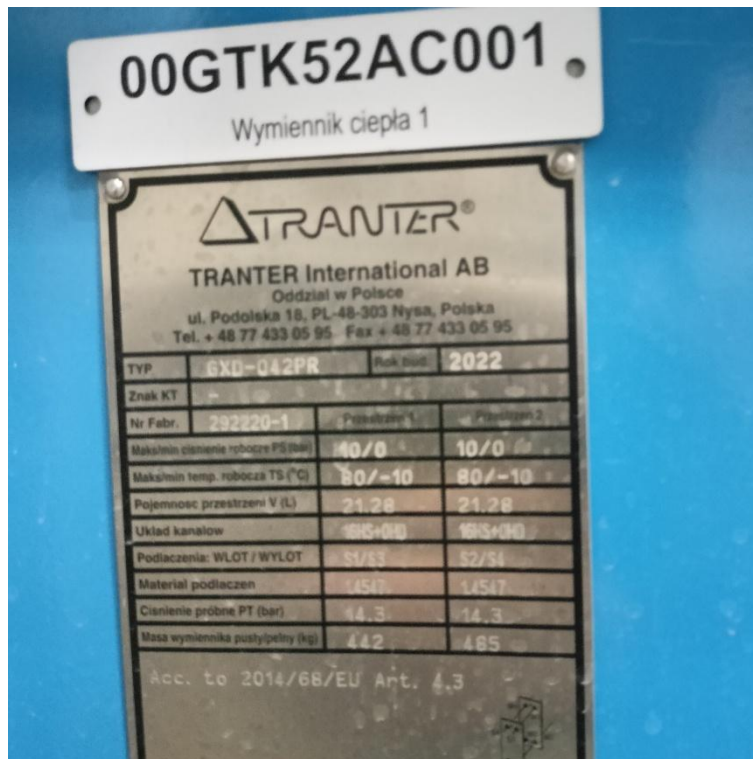
Zdjęcie nr 17 Tabliczka znamionowa wymienników na instalacji oczyszczania kondensatu UOC
