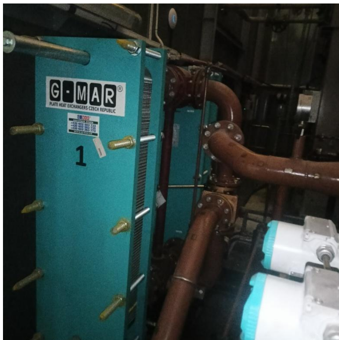
Zdjęcie nr 1 Widok ogólny wymienników na instalacji chłodzenia oleju turbinowego.
