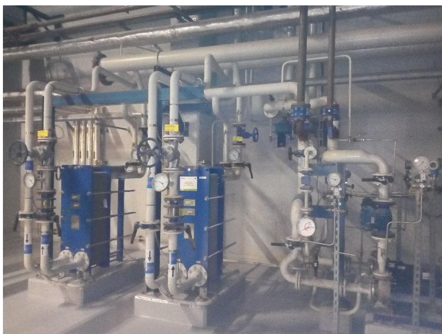
Zdjęcie nr 13 Miejsce podłączenia urządzenia czyszczącego do rurociągów wody chłodzącej
