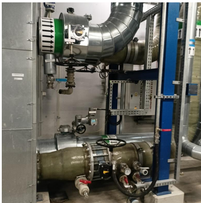
Zdjęcie nr 98 – Króćce przyłączeniowe wymiennika na instalacji UOC
