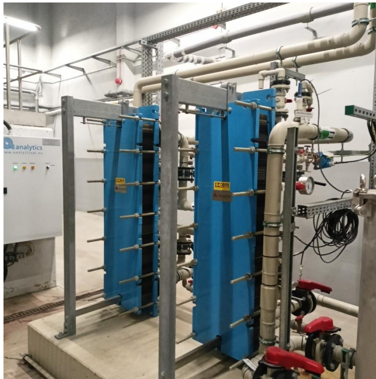
Zdjęcie nr 15 Widok ogólny wymienników na instalacji oczyszczania kondensatu UOC
